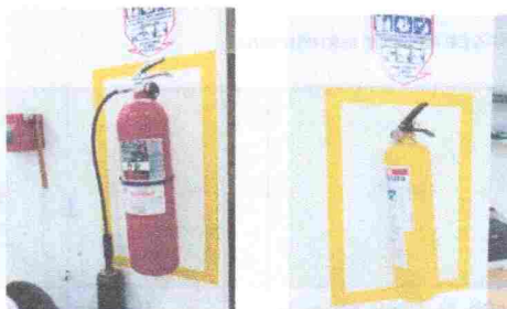
Extintores para líquidos inflamables o equipos electrónicos de operación (rojo) y para sólidos líquidos inflamables (amarillo)
